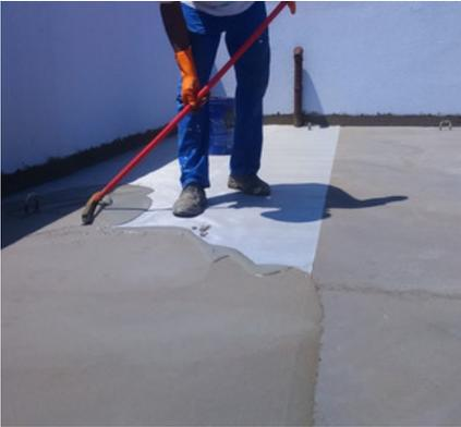
Adicione **BAUCRYL ECOLASTIC MULTIFIBRAS** em argamassas colantes tipo AC-I para torná-la impermeável.
