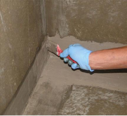
Adicione BAUCRYL ECOLASTIC MULTIFIBRAS ao cimento CP-II e obtenha a membrana de polímero acrílico dosada em obra para impermeabilização.
