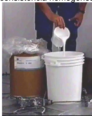
Figura 02 – Mistura do BAUCRYL 5.000 ou BAUCRYL® 10000 com Cimento
