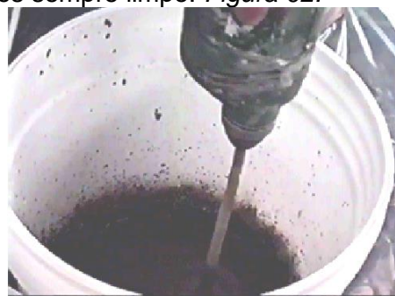
Figura 02 – Mistura do BAUCRYL 5.000 ou BAUCRYL® 10000 com Cimento
