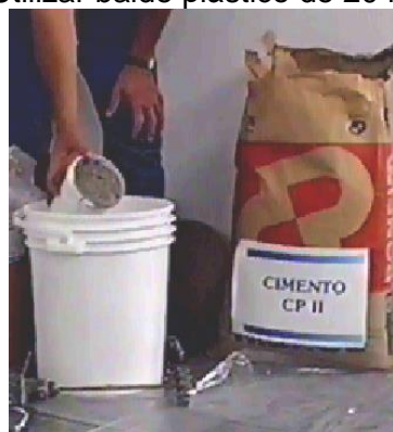
Figura 02 – Mistura do BAUCRYL 5.000 ou BAUCRYL® 10000 com Cimento
