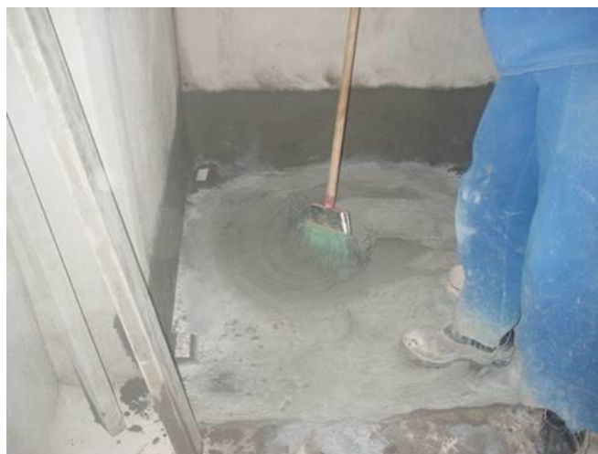
Figura 02 – Aplicação da Ponte de Aderência
