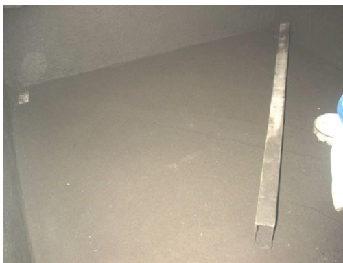
Figura 05 – Sarrafeamento do contrapiso
