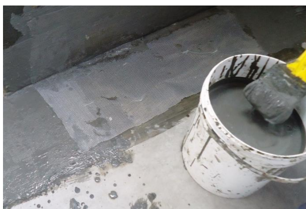
Colocação da tela no rodapé
