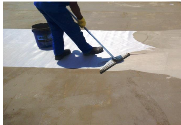
Aplicação do Estruturante com REV 4mm no piso
