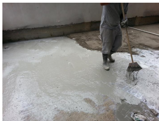
Aplicação da Ponte de Aderência no Piso
