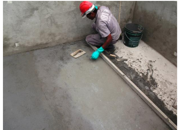
Sarrafeamento do contrapiso
