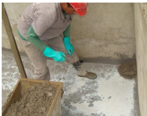
Execução da Talisca
