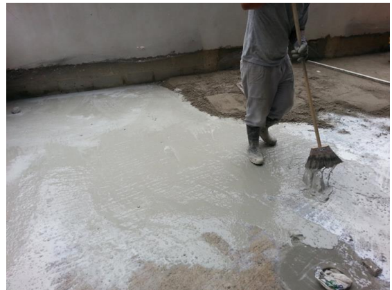
Aplicação da Ponte de Aderência no Piso
