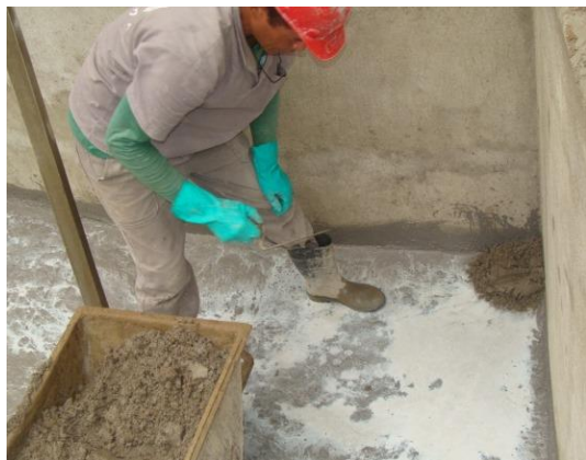
Execução da Talisca
